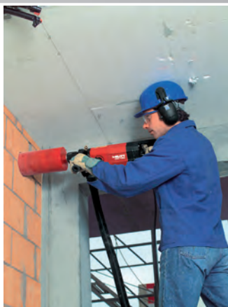
■ Gyémánt furatok vasbeton és téglá szerkezetekben
